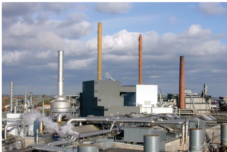
Det kræver en vedtægtsændring at kunne overtage Dong Energys biomassefyrede kraftvarmeværk hos Junckers Industrier i Køge.
