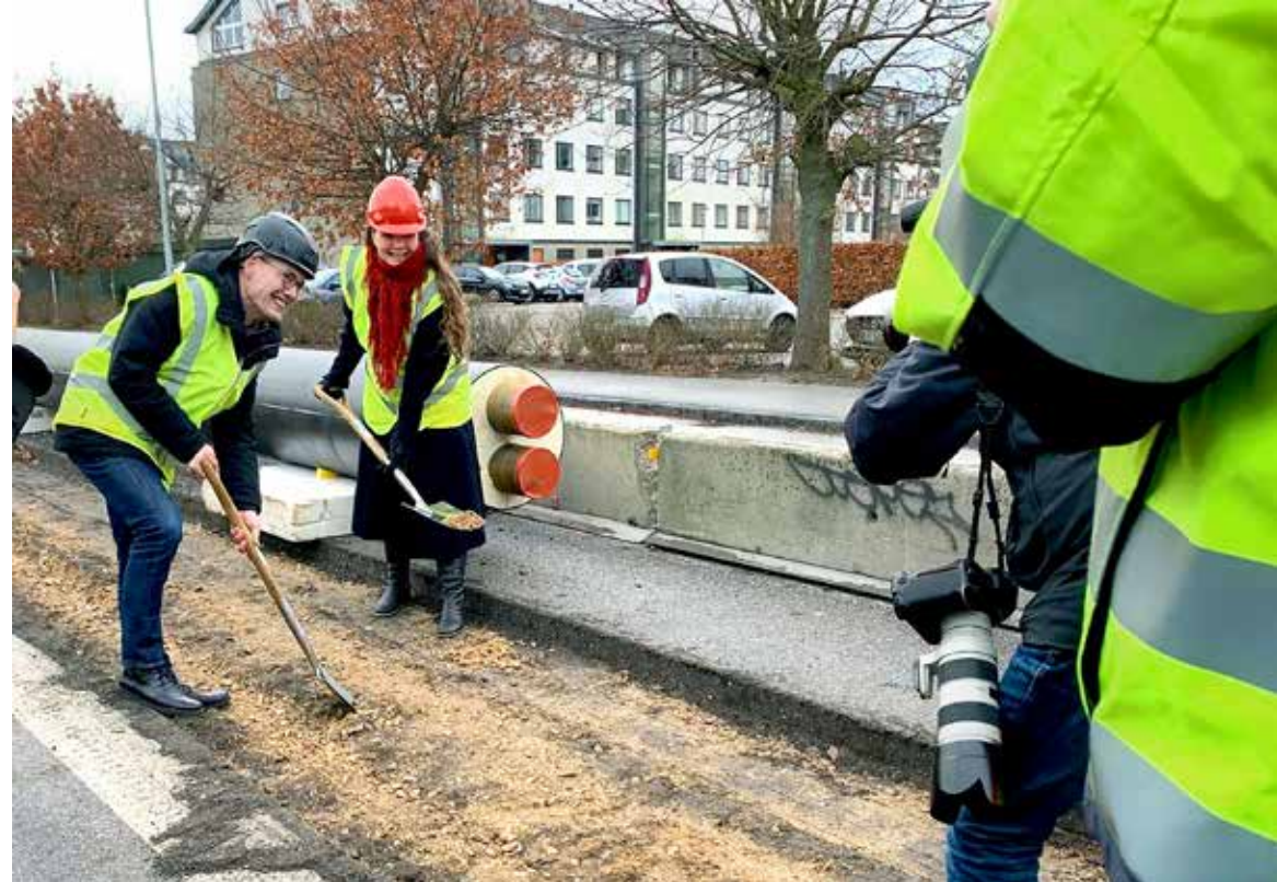
Head of Køge District Heating, Thomas Hopp, and Køge's Mayor, Marie Stærke. PHOTO: VEKS
